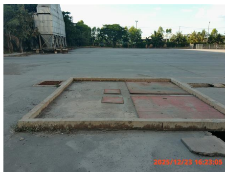
ภาพที่ 2-17 บ่อดักไขมัน (Oil Separator)
