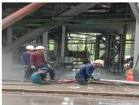
ภาพที่ 2-16 (ต่อ) รางระบายน้ำฝนและการขุดลอกรางระบายน้ำฝน
